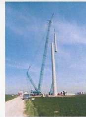
Figure 24 : Montage des éoliennes
